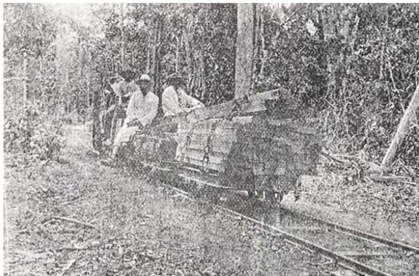
Figura 131 - Vagonetas Decauville usadas en la construcción del ferrocarril de Ambalema 564
